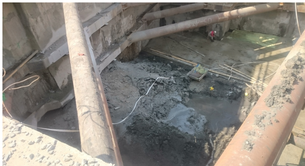
Рис. 2. Пригруз в зоне смещения грунта в котлован
