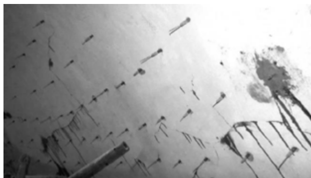
Рис. 2. Участок купола с выполненными работами по противоаварийному укреплению свода купола
