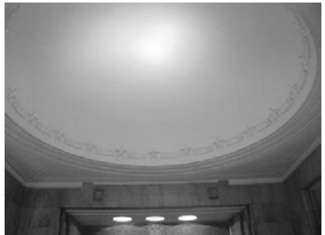
Рис. 1. Общий вид купола вестибюля
